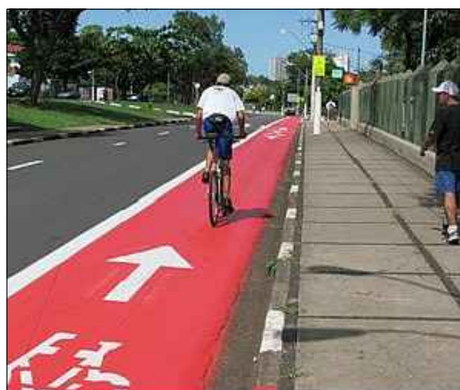
DETALHE IMPLANTAÇÃO DE CICLOFAIXA EM VIA URBANA
